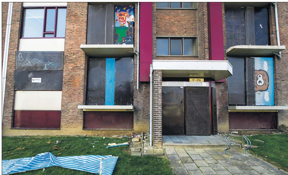
Woningen aan de Leenheerstraat in Brunssum staan op het sloopprogramma.
